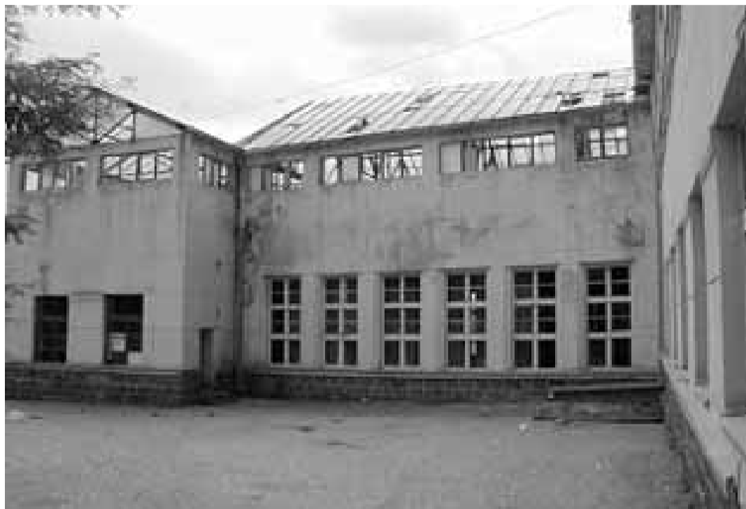
Edifici de l'Escola d'Agricultura, destruïda parcialment per les bombes.
