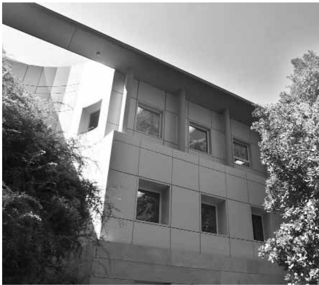
Façana del nou Edifici d'Investigació del Botànic.
