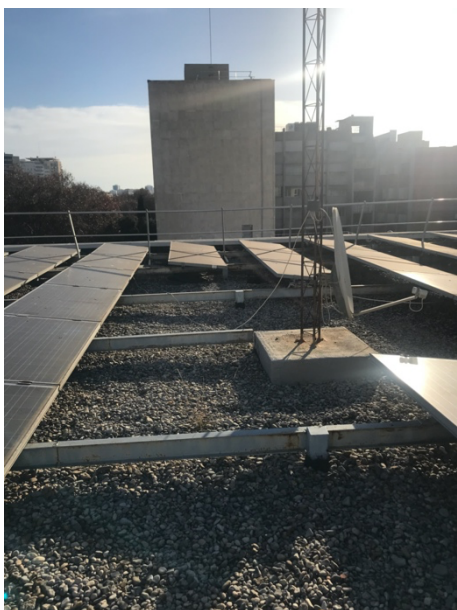
Foto 15 Anclaje antena
