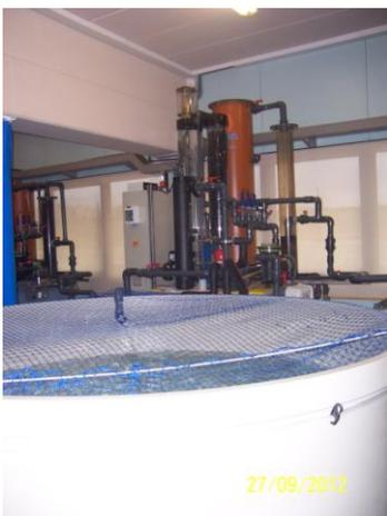
La planta ocupa 600 m<sup>2</sup> y está dividida en tres áreas contiguas (Zona húmeda, Cámara climática y Laboratorio). La instalación posee suministro de agua de mar esterilizada y agua dulce de clorada y esterilizada, con la posibilidad de regular la temperatura del agua. Tiene suministro de aire a presión, está climatizada y posee un sistema para el tratamiento de los vertidos.
