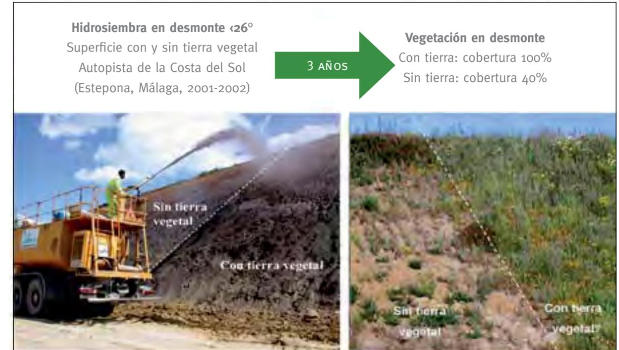
**Figura 18.** El efecto de la adición de tierra vegetal en la cubierta vegetal en un desmonte hidrosiembrado de la Autopista de la Costa del Sol (Málaga) fue muy patente desde un principio, así como tres años después del tratamiento. La cobertura en las zonas con tierra vegetal fue muy superior a la de las zonas sin tierra vegetal durante todo el periodo de seguimiento (3 años). Extraído de Valladares *et al.*, 2004.
