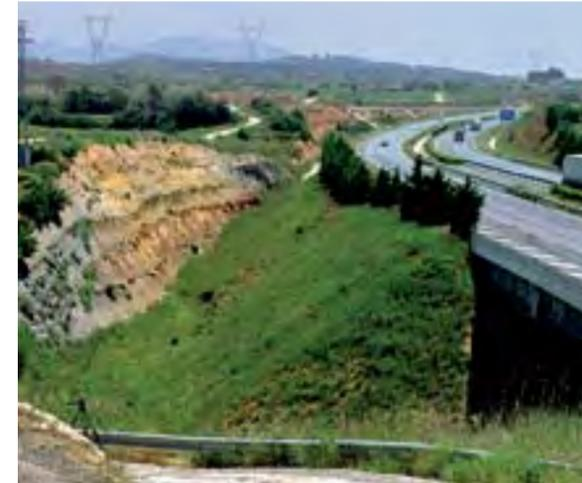
**Figura 8.** Diferencias en la densidad de cobertura vegetal alcanzada en un desmonte (izquierda) y un terraplén (derecha) próximos a la Autovía A-3 (Requena, Valencia). Las diferencias se deben principalmente a la orientación (norte en este caso concreto) y condiciones del suelo más favorables para el establecimiento de las plantas en el terraplén. El establecimiento de las plantas en el desmonte orientado hacia el sur es prácticamente nulo (Foto: Esther Bochet).
