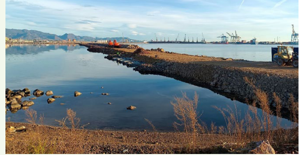
Ejecución mota de cierre
