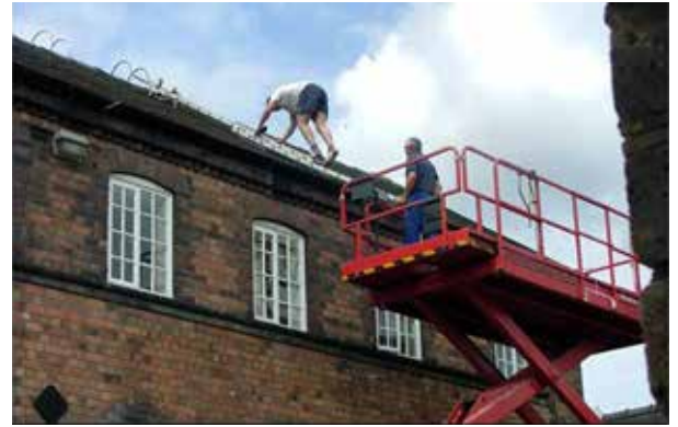
Figura 30. Uso indebido de la PEMP.
