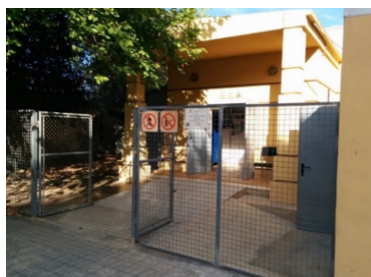
Fig. 14. Ejemplo de acceso controlado de un almacén de residuos peligrosos (Fuente: fotografía proporcionada por un laboratorio participante)
