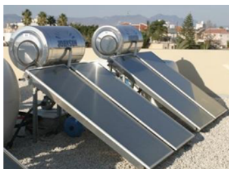
Fig. 25. Diagrama de un sistema de calentamiento de agua mediante paneles solares, y fotografía de un panel solar que calienta el agua situada en el interior del depósito, en Chipre (Source: http://www.3m.co.uk/intl/uk/3Mworldly-wise/primary-bldg-southside-6-solar-panel.htm , http://www.solarthermalworld.org/content/cyprus-system-replacements-increase-efficiency )
