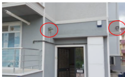
Fig. 22. Un ejemplo de uso de sensores de iluminación automáticos en un laboratorio (Fuente: imágenes proporcionadas por un laboratorio participante)
