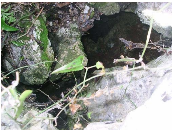
Boca A12 antes de desobstruir
