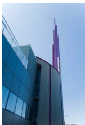
Edifici 1 SC de Serveis Cientificotecnològics del Parc Científic
