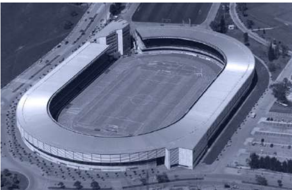
Img 14. Ampliación del Estadio Chapín. (Cruz y Ortiz Arquitectos)
