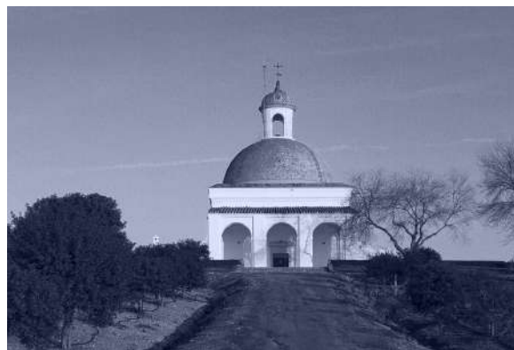
Img 34. Ermita de Salto al Cielo (Entorno a Jerez)
