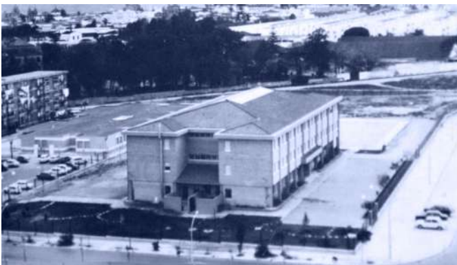
Img 11. Colegio La Unión recién construido, 1980.
