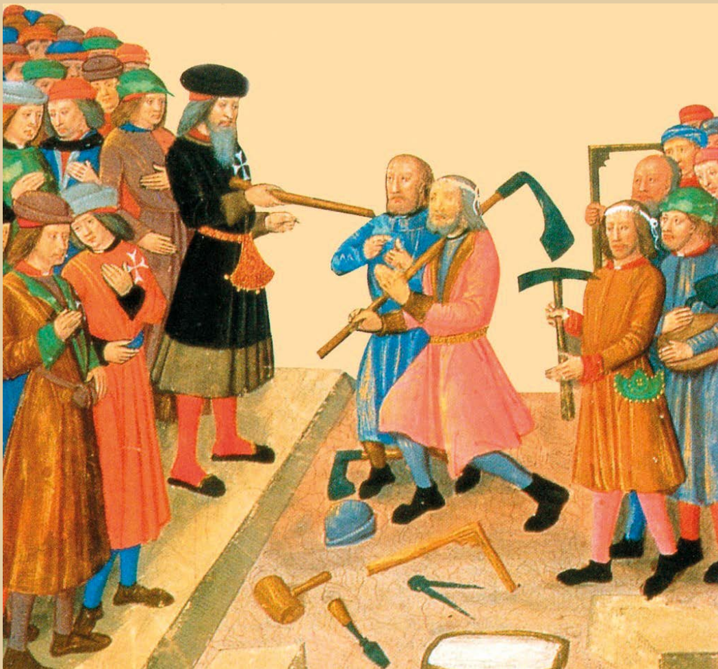
// Fusters i mestres d'obra davant d'un cavaller.
