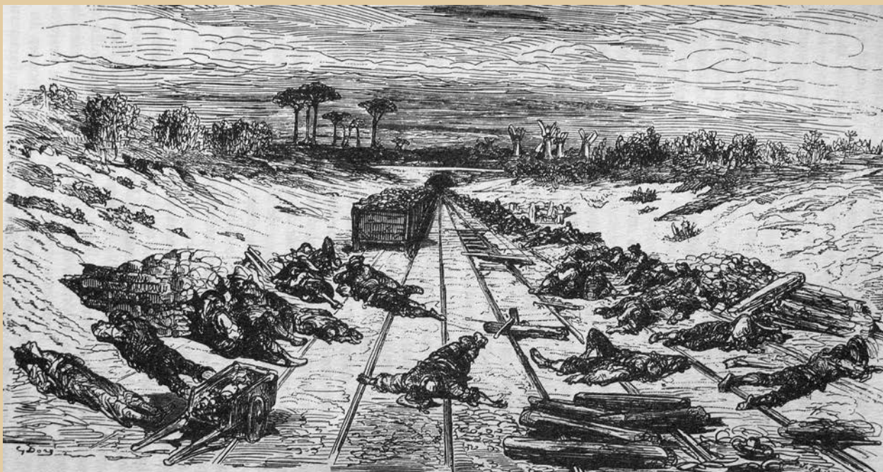
// Treballadors i travesses de ferrocarril a Argamasilla.
