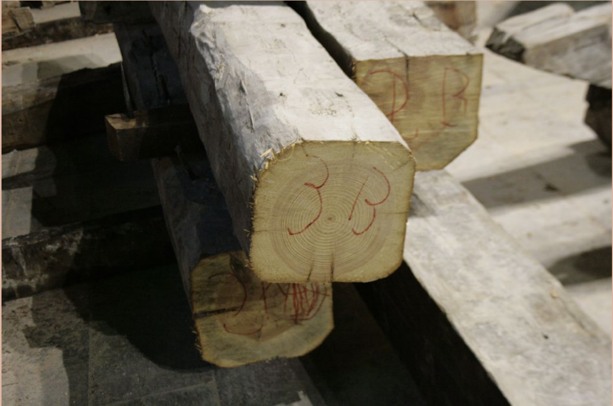
Sección de los pares numerados para su posterior montaje.
