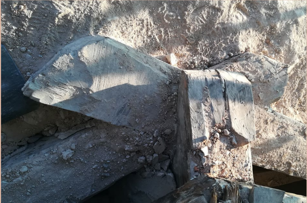
Encuentro de dos durmientes y apoyo de viga en el ábside.
