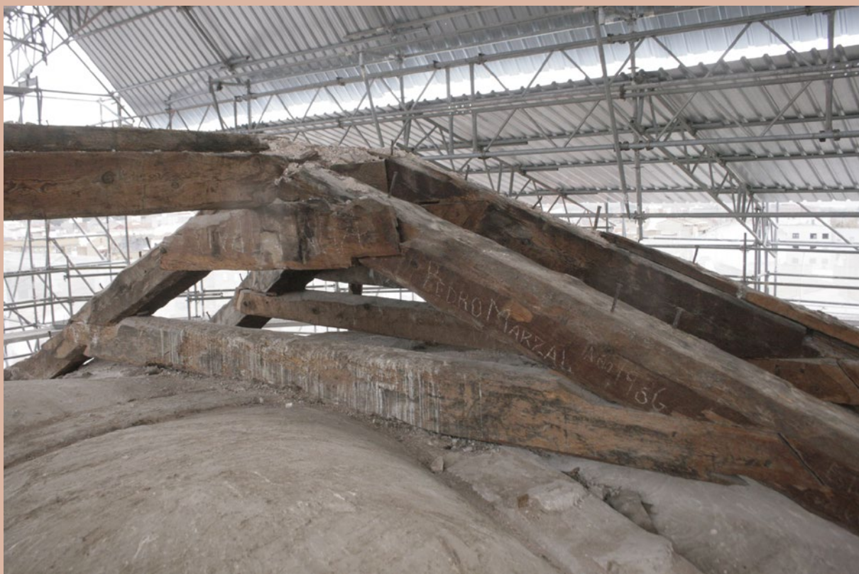
Cercha con pares y tirante. El tirante apoya en la bóveda con peligro de caída.
