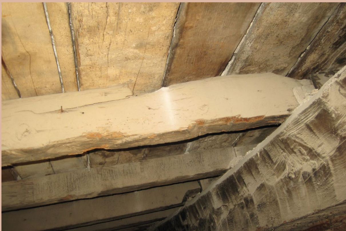
Detalle de los daños de las correas y el tablero de madera.
