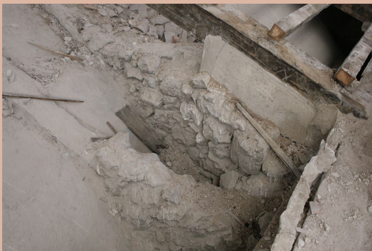
Apoyo de un par y las correas.
