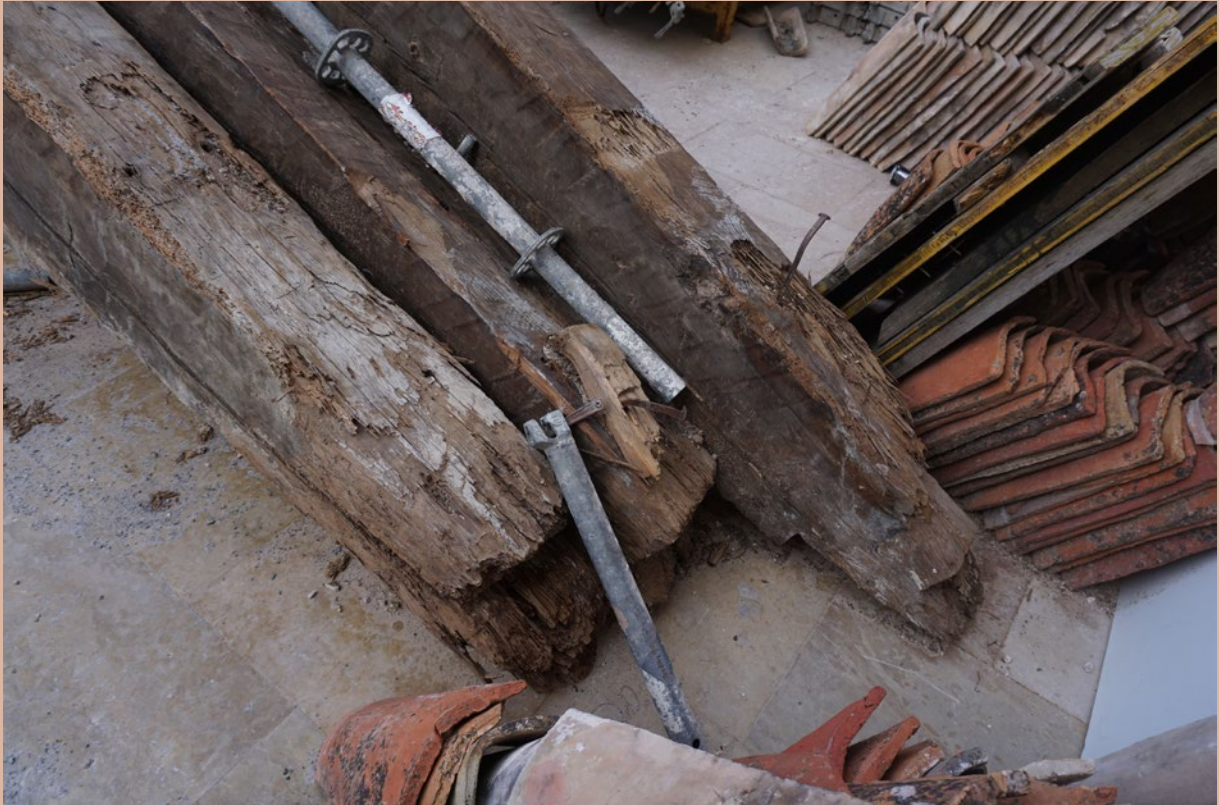
Daños por pudrición y termitas de las cabezas de los pares.
