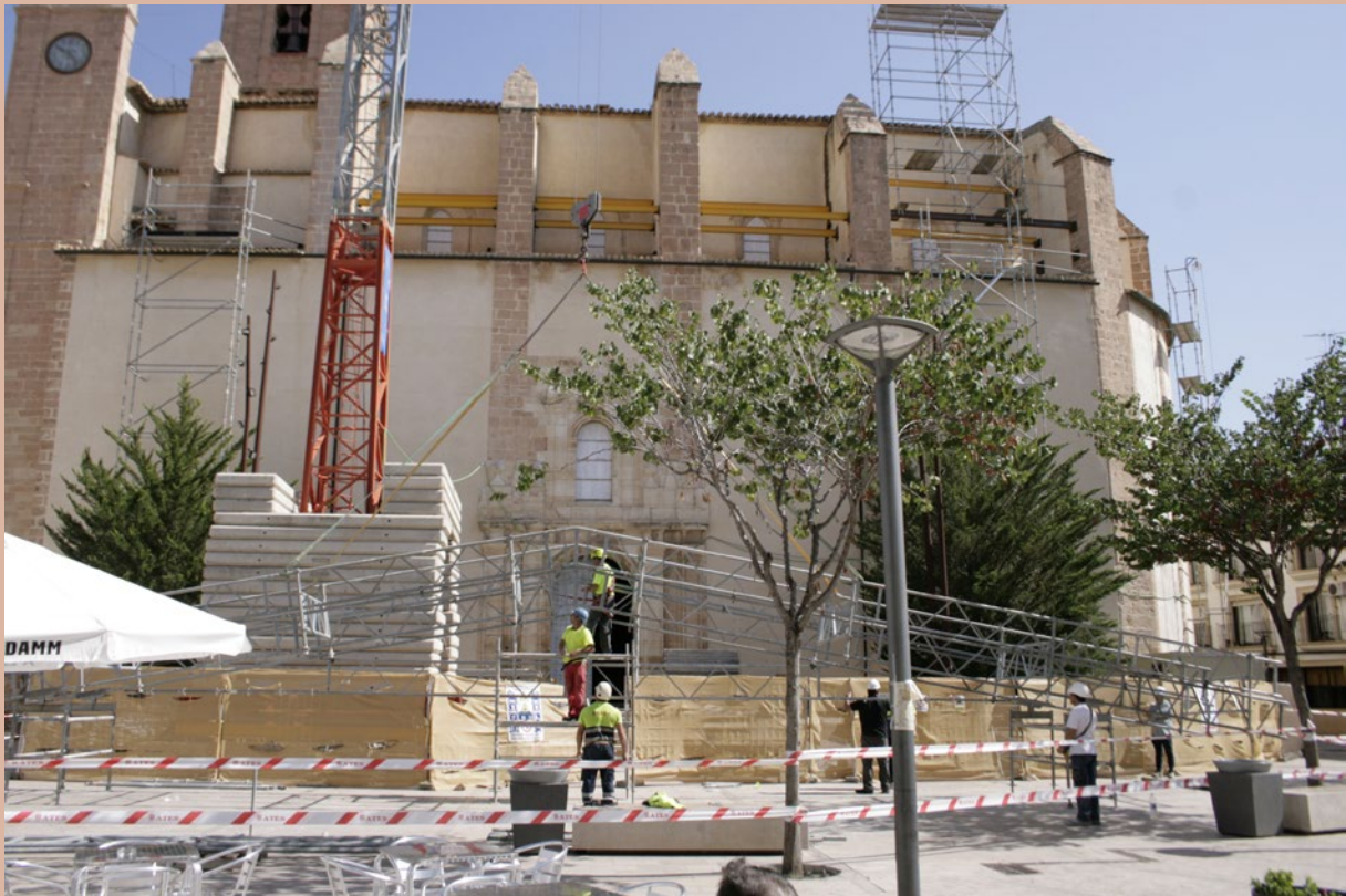
Izado de la estructura de la sobrecubierta.
