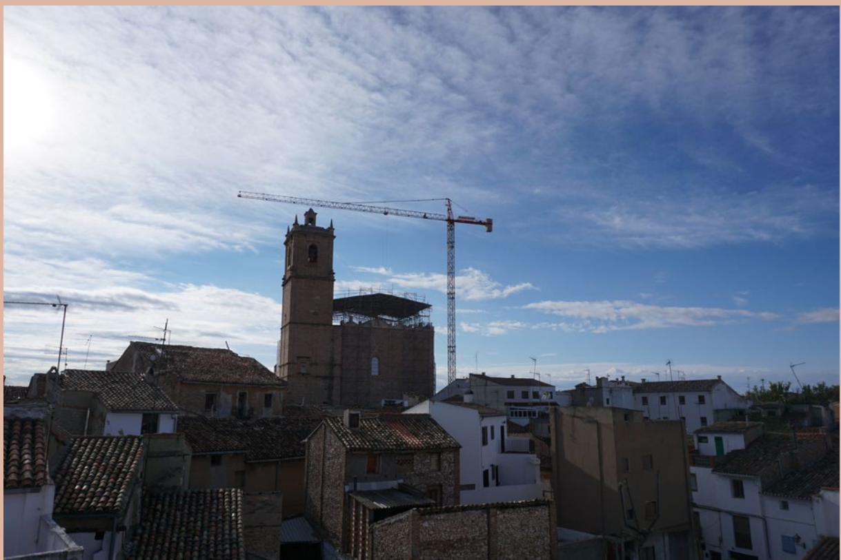
Sobrecubierta para protección durante el desmontado de la cubierta.
