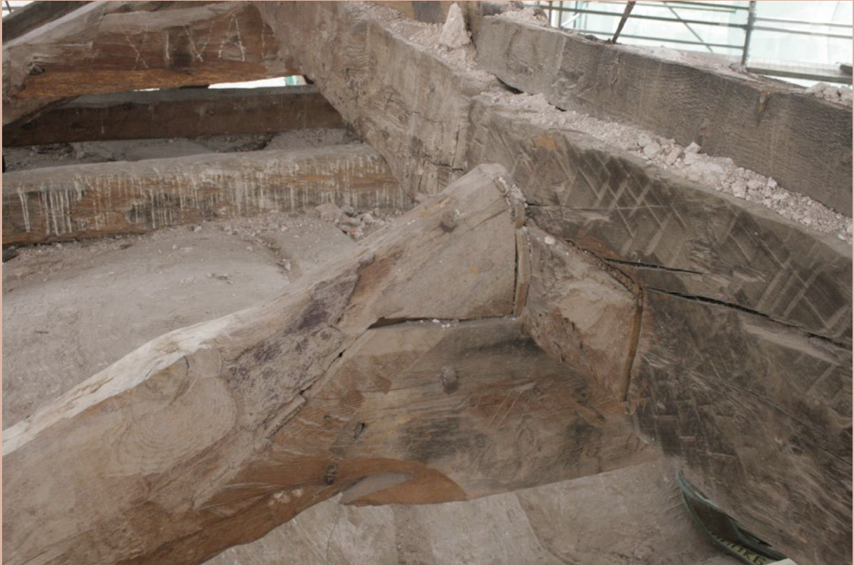
Apoyo de la viga de hilera sobre la viga de par. Se aprecian las marcas de golpes del corte de la hachuela.
