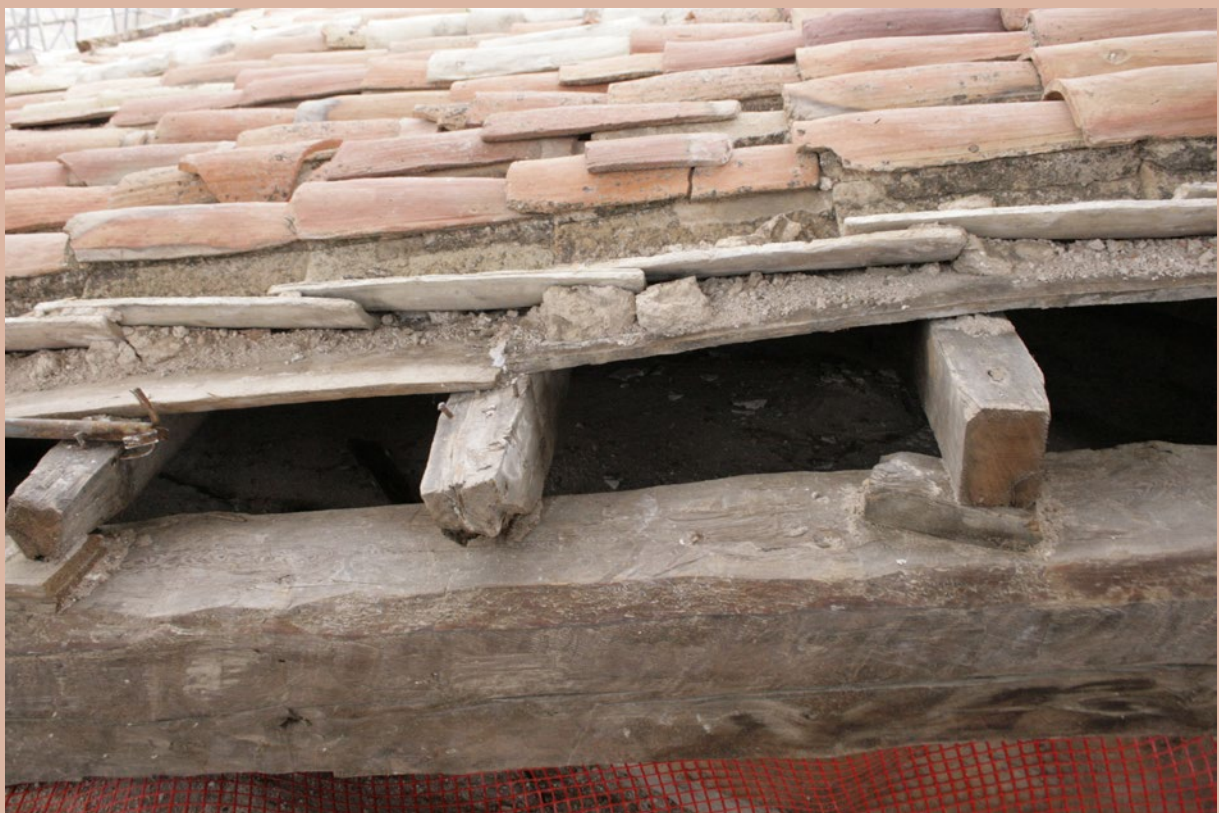
Sección constructiva de la cubierta. Sobre el par apoyan las correas que sustentan el tablero de madera, la capa de tierra y las tejas.
