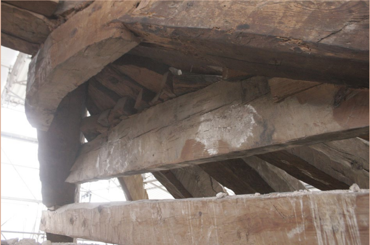
Vista inferior del nudo de encuentro de las vigas del ábside.
