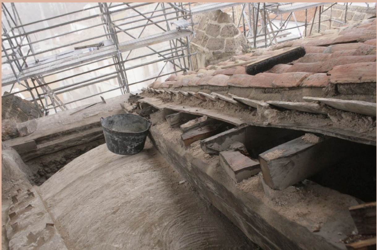
Sección de la cubierta. De arriba hacia abajo se ven las tejas sobre la capa de gravas con tierra, debajo el tablero de madera que apoya sobre las correas y estas sobre el par de madera.
