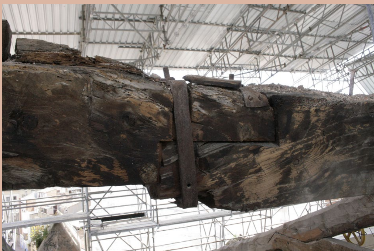
Unión a media madera con refuerzo de anillo de hierro.
