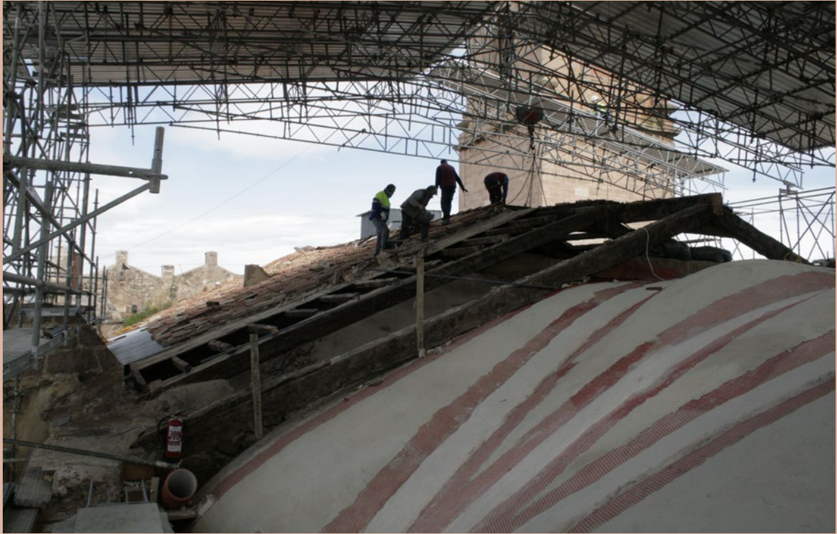
Trabajos de desmontado de la cubierta.
