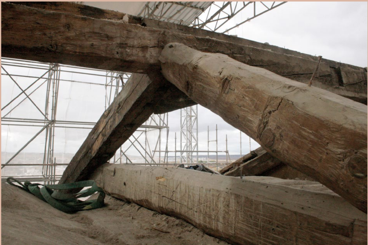
Viga de hilera apoyada sobre la cercha con los dos pares y el tirante.
