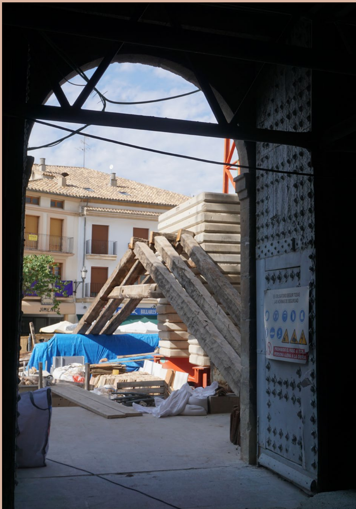
Acopio provisional de las cerchas desmontadas en la plaza del Ayuntamiento.
