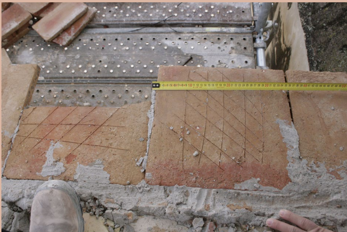
Desmontado del alero formado por rasillones cerámicos de 1 pie (34x34 cm).
