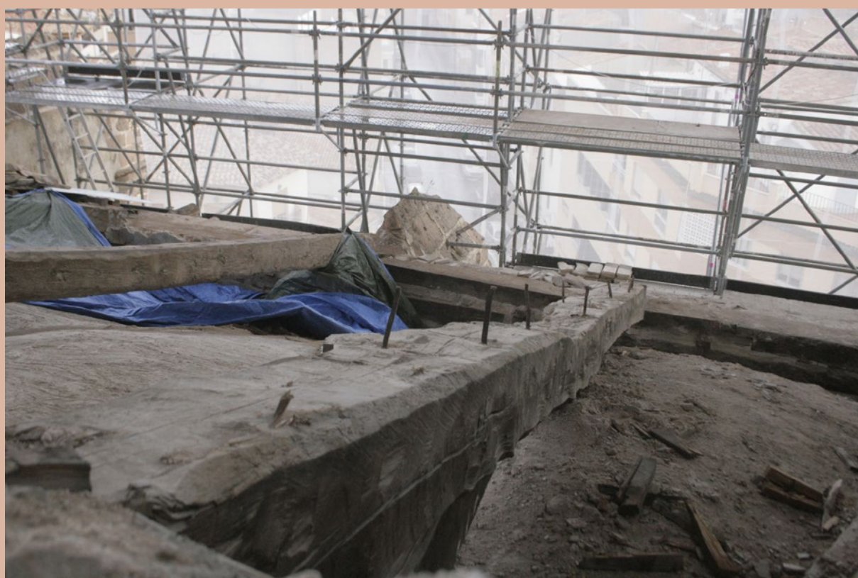
Clavos de fragua para sujeción de las correas.
