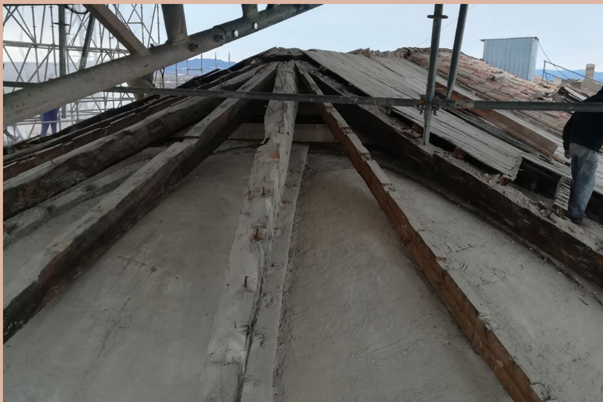
Vigas del ábside. Al apoyar en las bóvedas ponían en peligro la su estabilidad.
