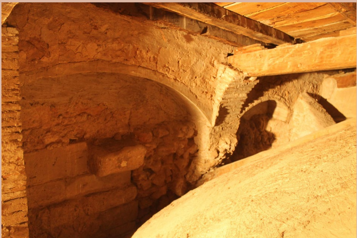
Sistema de arcos de ladrillo para apoyo de las cerchas en el campanario.
