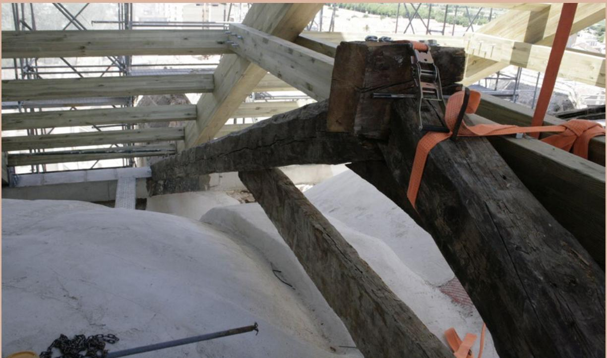
Cercha de la cubierta original reposicionada como testigo junto a las nuevas cerchas. Se puede comparar el tamaño de ambas.
