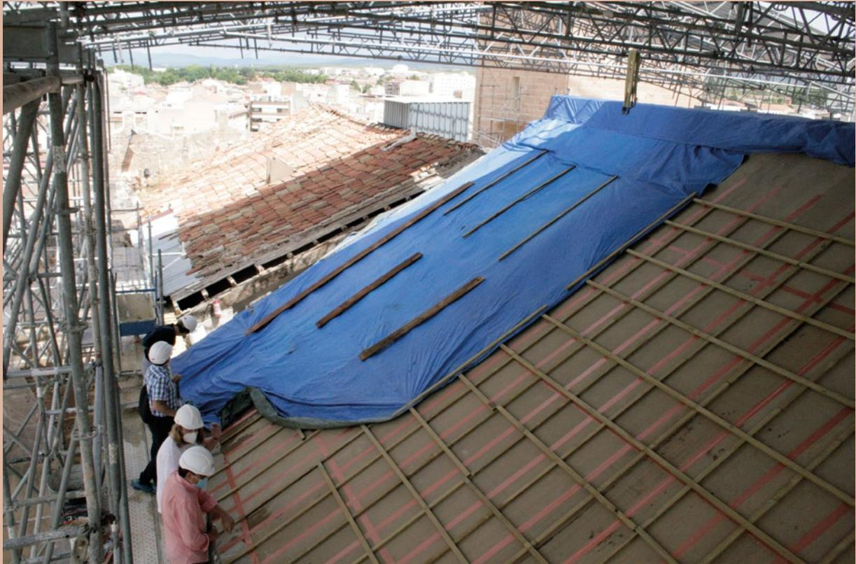
Montado de la tela impermeable sobre el tablero de panel sandwich.
