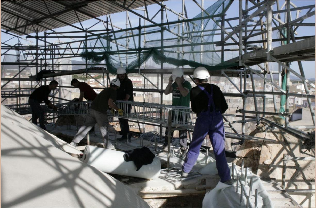
Montaje de la armadura del zuncho de coronación de los muros.
