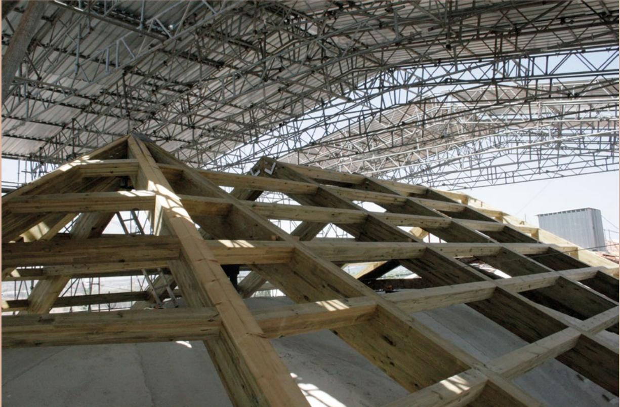
La estructura de cubierta luego del montaje de las cerchas y las correas.
