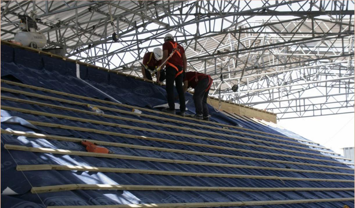
Extendido de la tela impermeable y montaje de rastreles.
