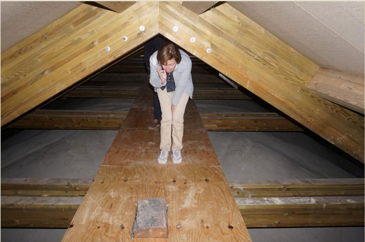
Interior de la cubierta. El tablero permite un fácil acceso en toda su longitud.
