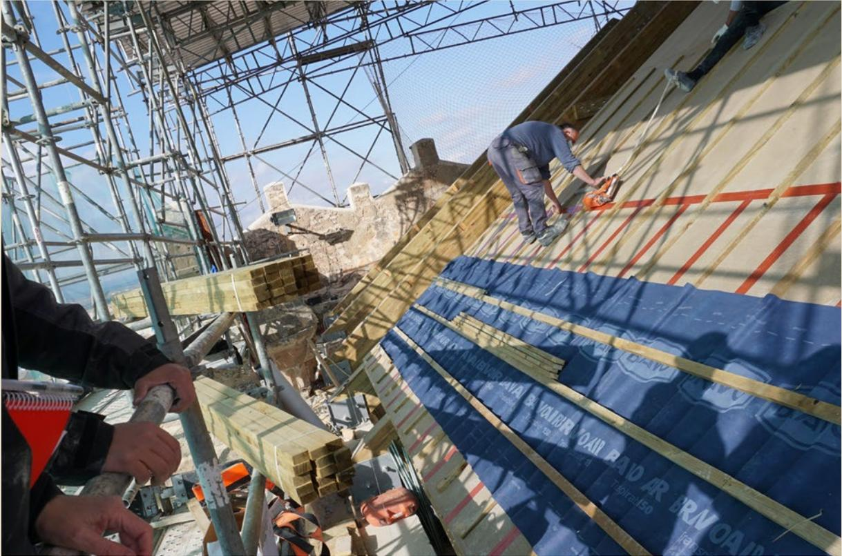
Colocación de la tela de impermeabilización y los rastreles de madera para apoyo de las tejas.
