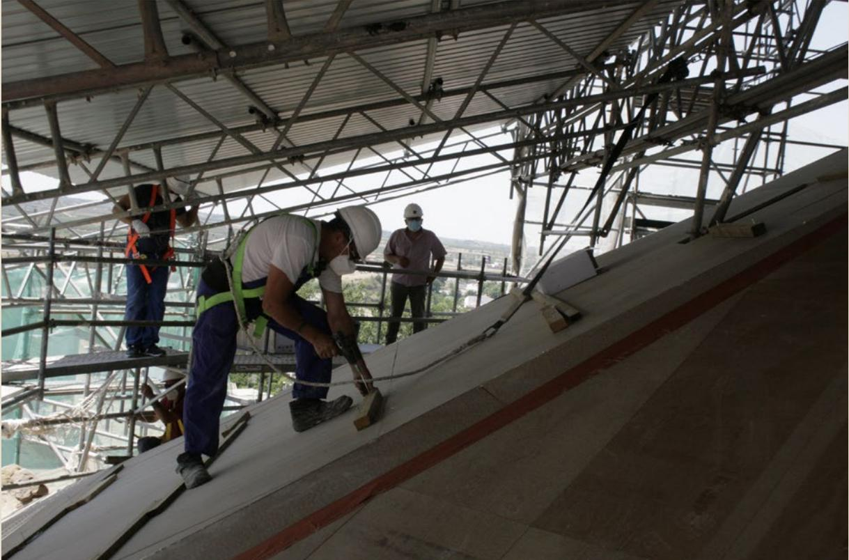
Colocación del enrastrelado sobre el tablero de panel sandwich.
