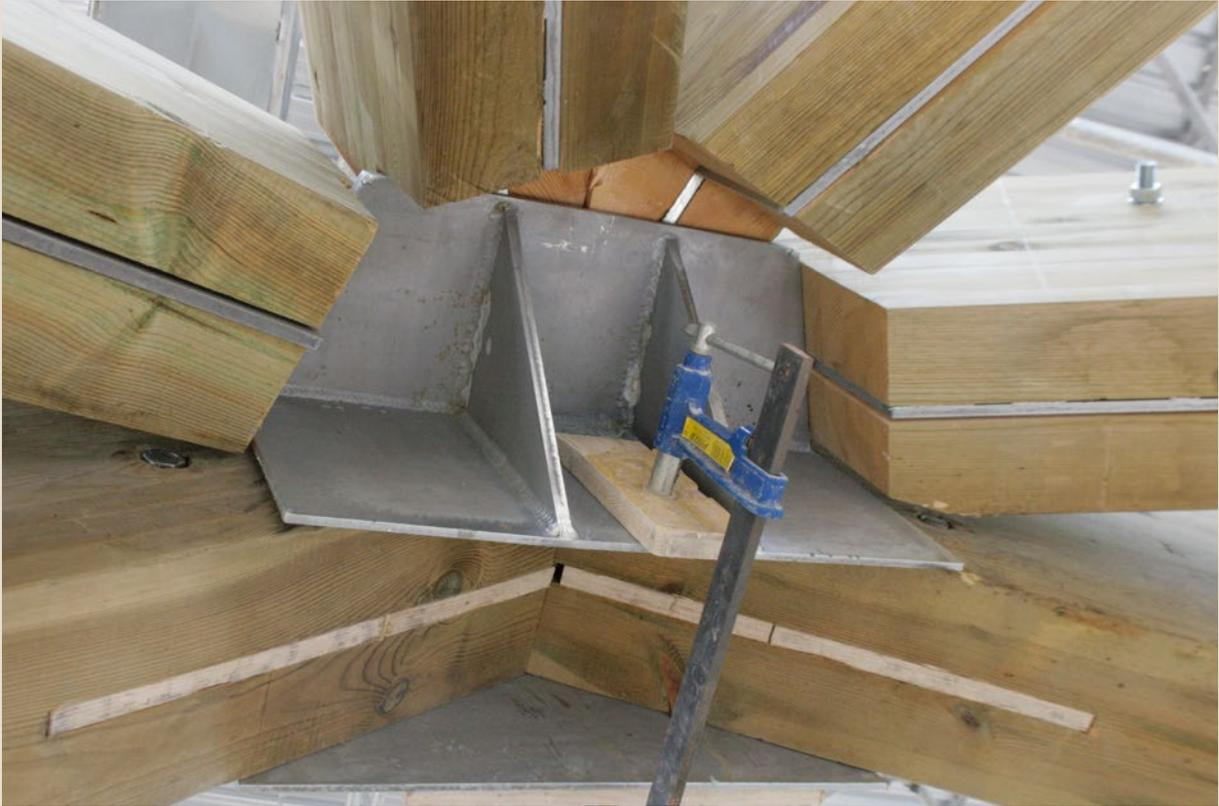
Cartela de acero galvanizado para unión de las vigas del ábside.
