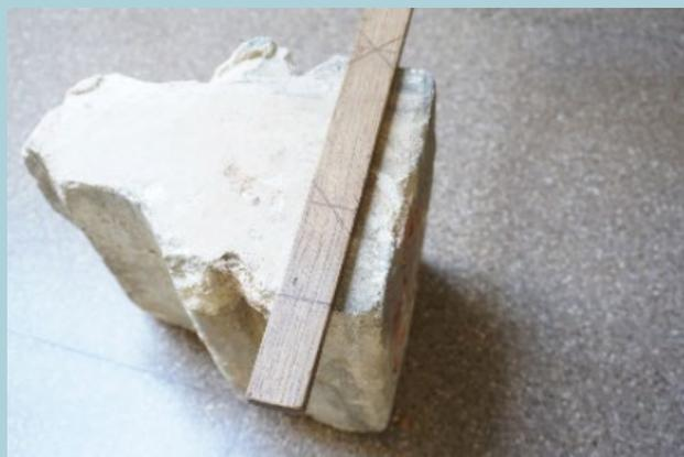
Las incisiones en el árbol permitían la entrada del mortero de cal en la junta entre dovelas. Las proporciones se ajustan a las medidas de la vara valenciana
