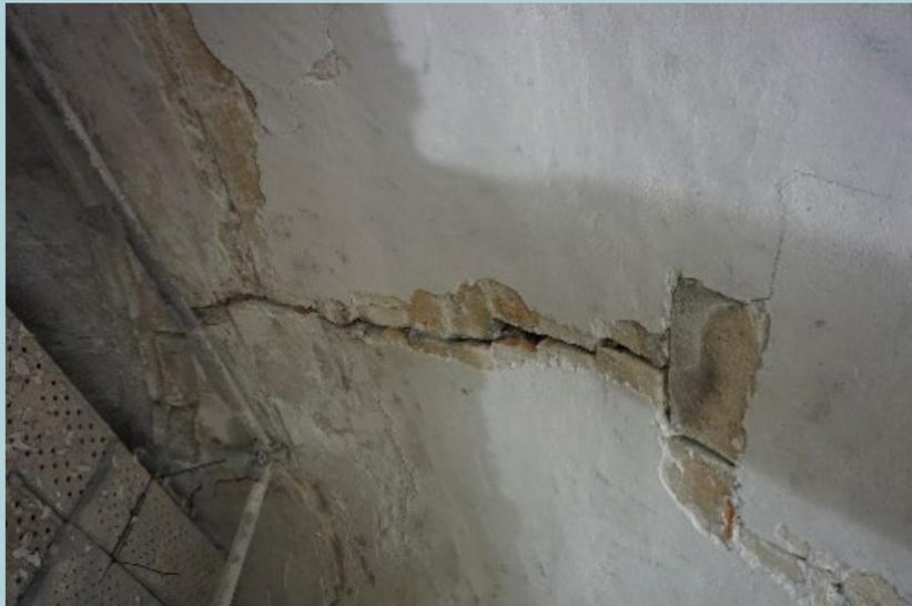
En los plementos las grietas y las fisuras hacían peligrar su estabilidad. La humedad afectaba a una parte importante de su superficie.
