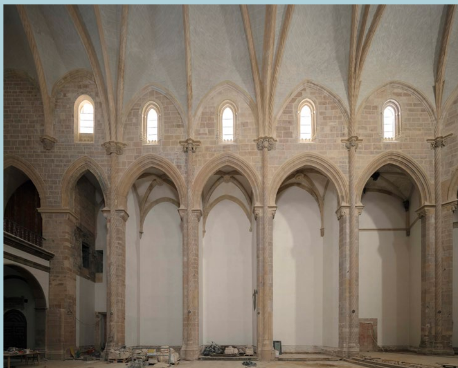
Vista interior lado del evangelio tras la restauración.
