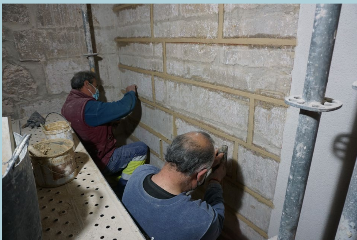
Ejecución de junta resaltada en pareses de sillaría.
