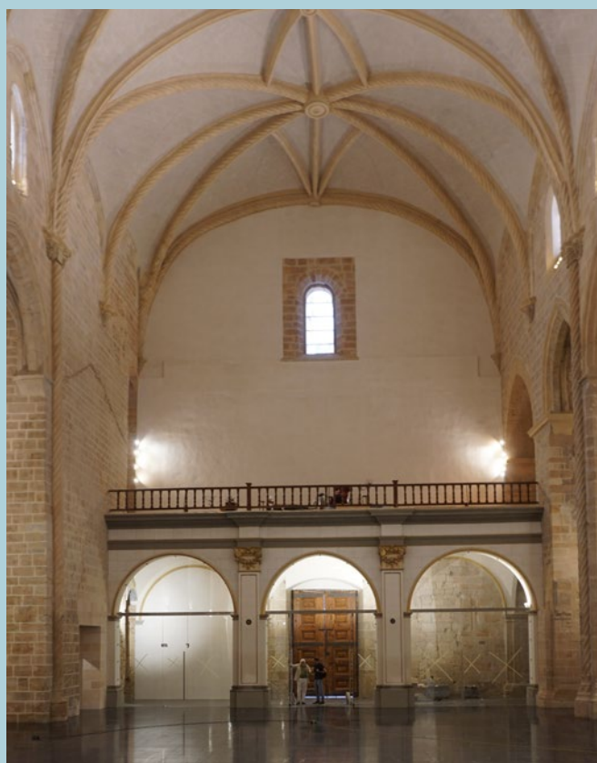
Vista nave central hacia el imafronte tras la restauración.
