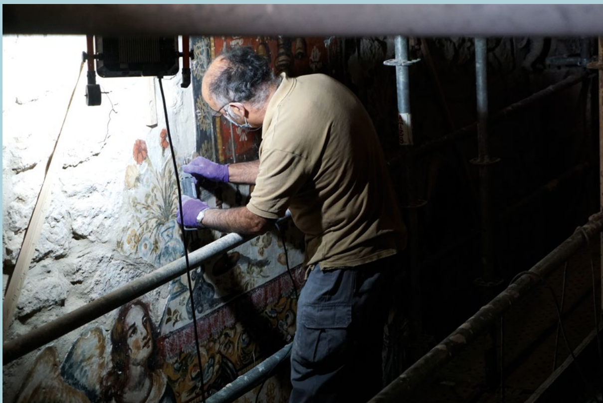
Trabajos de fijación de la capa pictórica al soporte.
