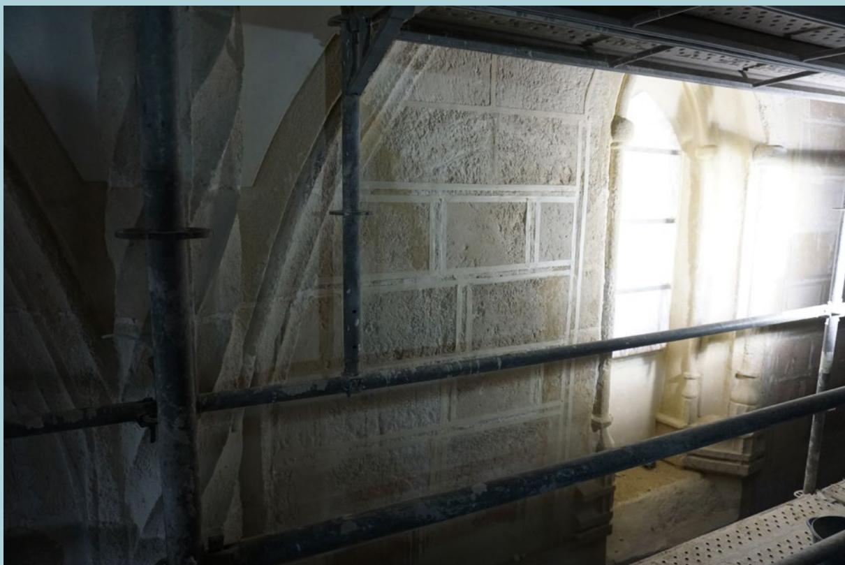
Replanteo de preparación para el dibujo de despiece de sillares.
