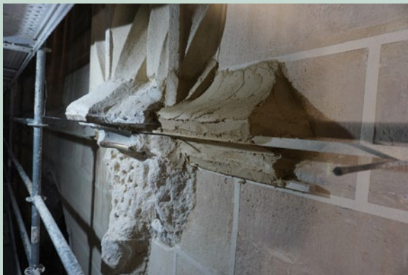
Proceso de recuperación del volumen de un dosel o cimacio.
