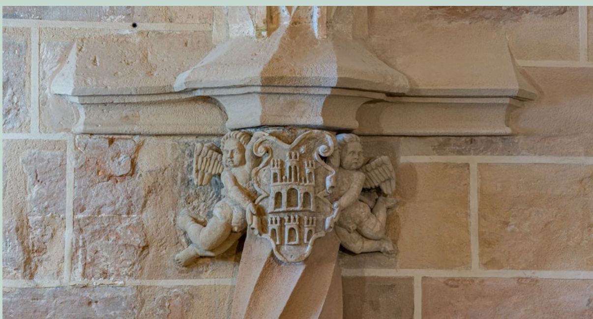
CB-2, CB-3 y CB-10. Escudo de la villa de Utiel, como promotora y principal financiadora de las obras. ©Joan Roig.
