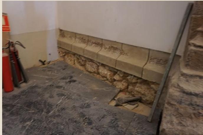
Reposición con morteros del volumen con moldura en caveto.
