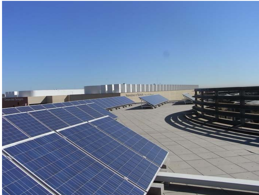
Foto: Instalaciones fotovoltaicas del Edificio de Servicios del Campus dels Tarongers
