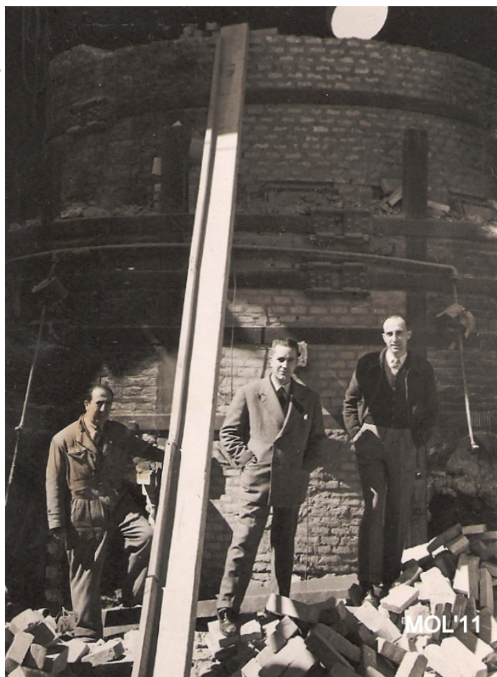
Figura 19. Antonio Testón, Salvador Valero y Eduardo Mira ante uno de los nuevos hornos “de botella”, en construcción.
