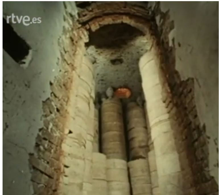
Figura 20. Uno de los antiguos hornos, abierto para disponer las arquetas que contenían las piezas a cocer.
