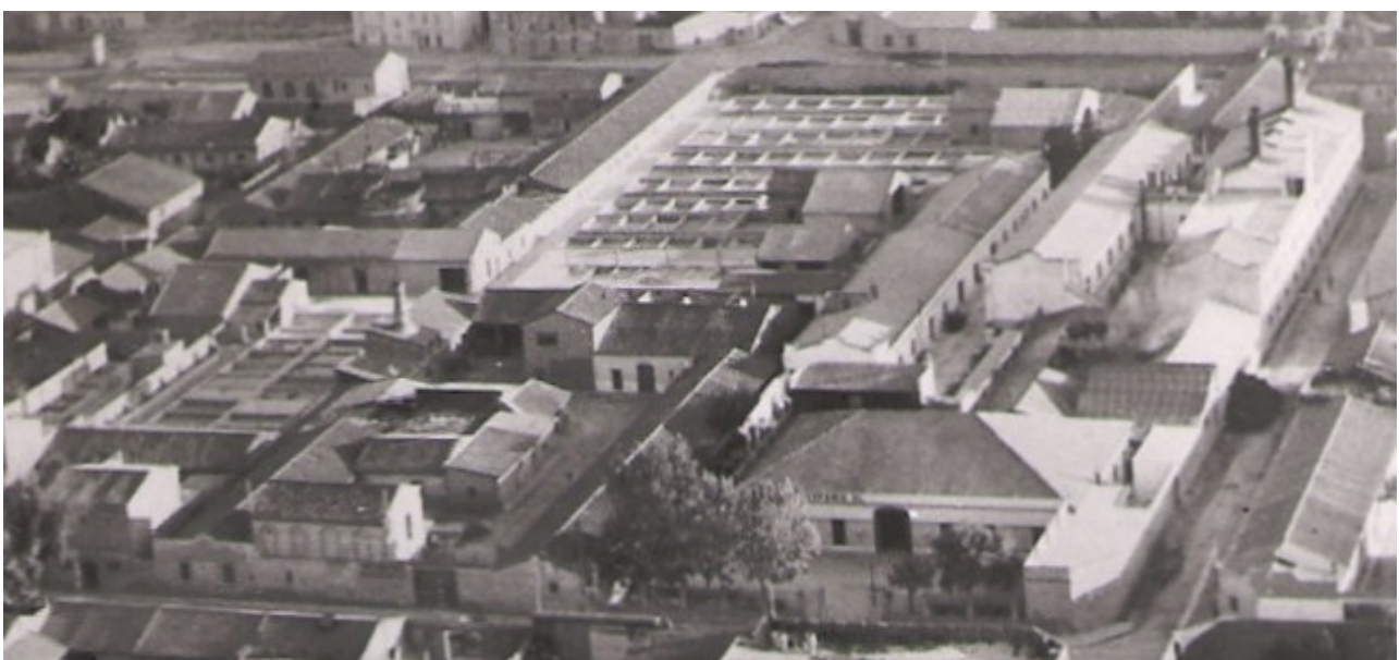
Figura 5. Instalaciones de Cerámicas Hispania, ya en 1960. En primer plano la fachada recayente a la Carretera de Ribarroja.
