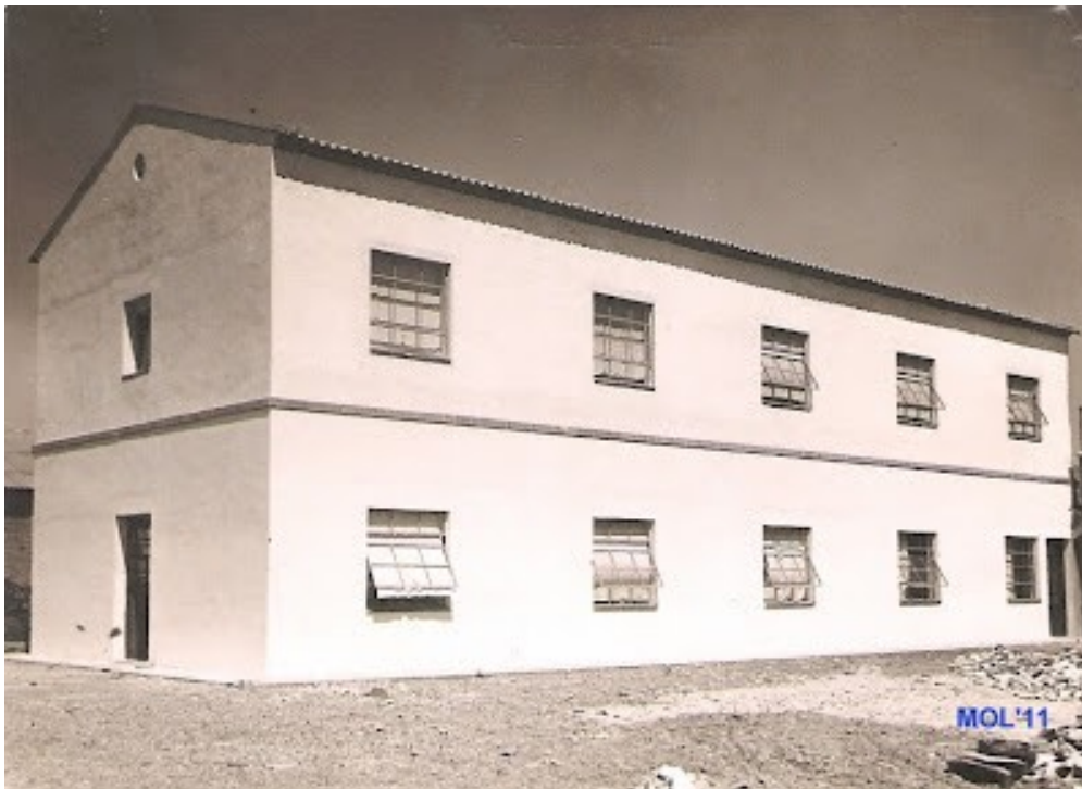
Figura 4. La primera de las nuevas naves que se construyó.
