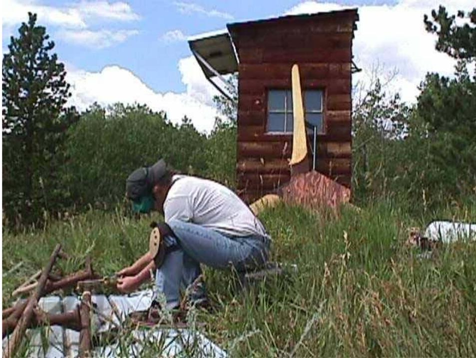
Para fabricar la torre estamos usando los restos de una escalera. Uno de sus tubos es de 2" soldado a otro tubo de 1 ½". Una de las secciones nos servirá de base de la torre y la otra nos servirá de brazo de izamiento. En la fotografía estamos cortando lo que necesitamos para soldarlo posteriormente a su forma final.
