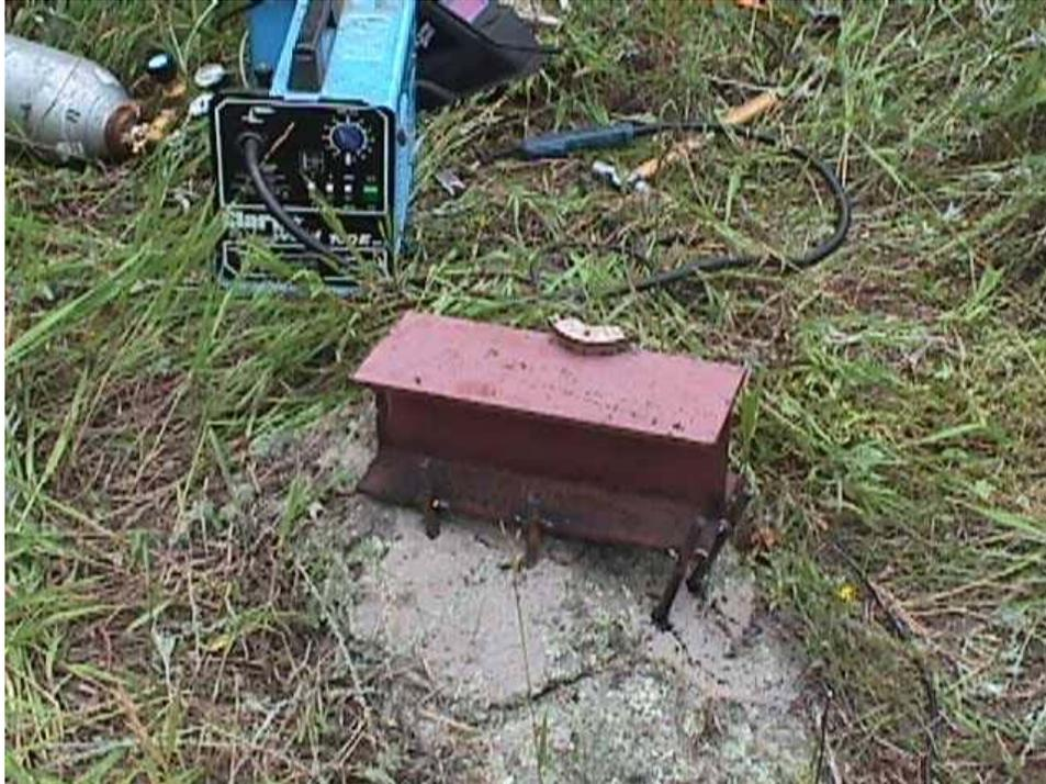
El trozo de viga ha sido soldado a las cabillas. Lo normal es fabricar una base plana y nivelada. En la montaña esto no es posible. Para subir la torre no dispondremos sino de un solo cable para subir y bajar la torre. Esa base debe ser muy resistente. En un sitio plano las cosas cambiarían.
